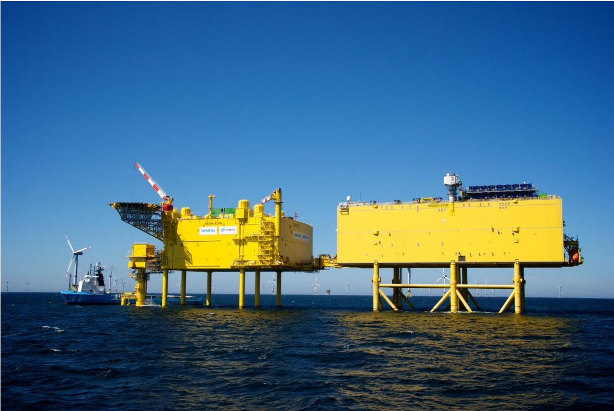
Bild 2 – Nur funktionierende Löschanlagen schützen optimal vor Bränden! – Das gilt auch auf der Nordsee. HelWin beta Copyright TenneT
